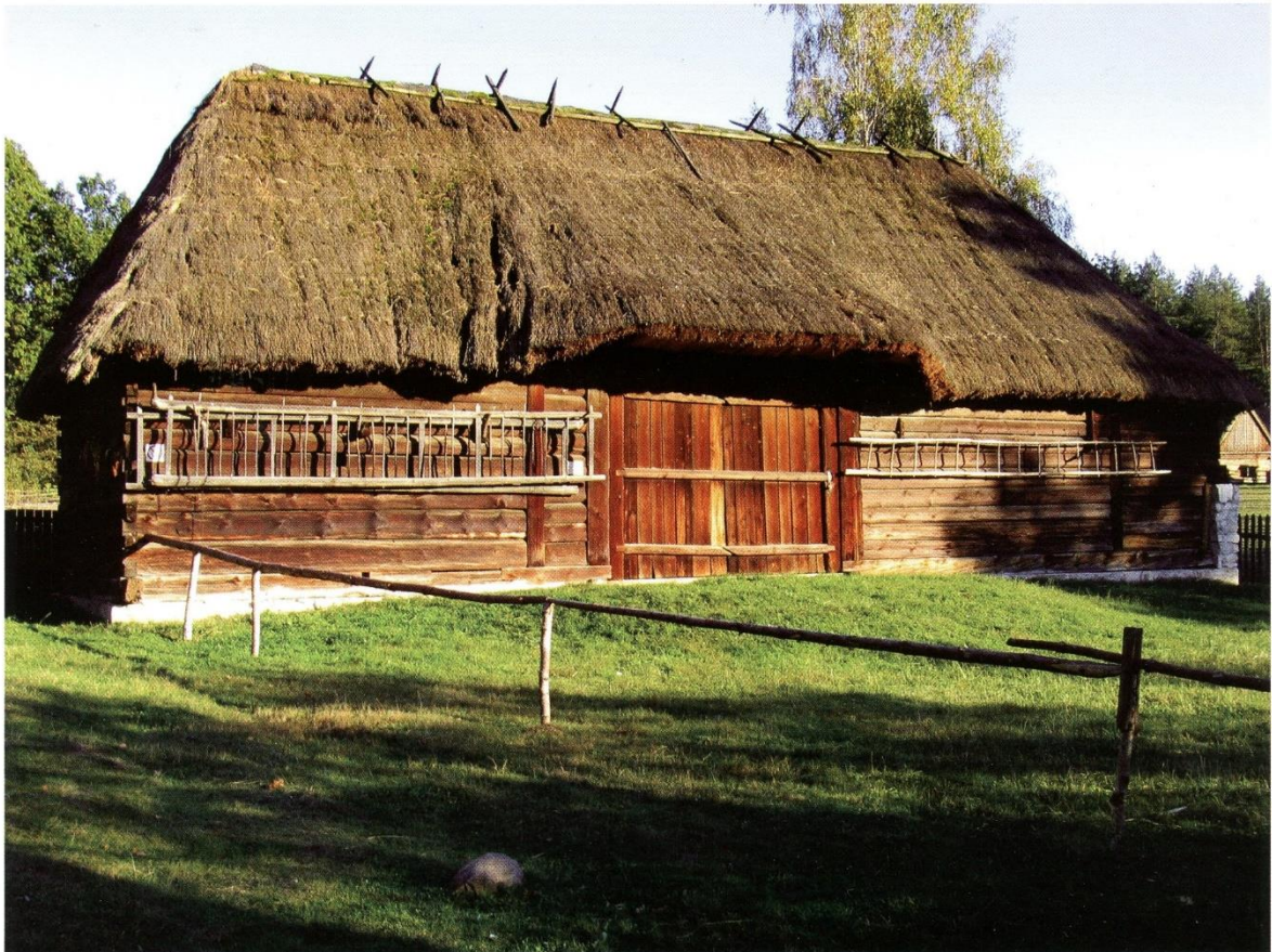
Stodoła konstrukcji zrębowej i łątkowej, dach czterospadowy kryty strzechą
